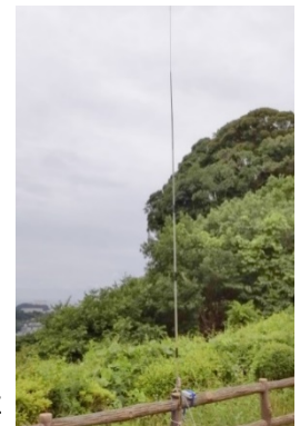
6.1m アンテナの全景
